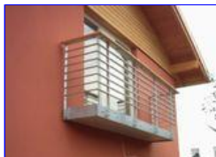
Balkone Setzen Sie mit uns Akzente: maßgeschneiderte Balkone von Metallbau Rysiok.
