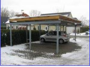
Carports sind als Maßanfertigung in individueller Optik herstellbar. Die Dacheindeckung kann lichtdurchlässig gestaltet werden, aber auch als klassisches Flachdach oder Gründach ausgeführt werden!
